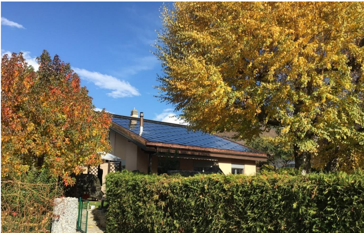
Figure 1 : Photographie du toit solaire.
