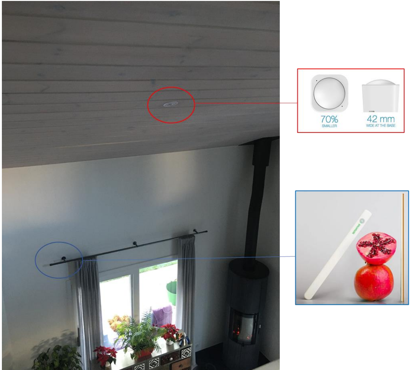
Figure 4: vue du salon depuis la mezzanine. On distingue les deux capteurs de température.
